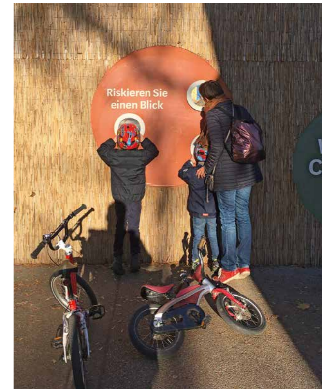
Gucklöcher laden zum Blick auf die Baustellenarbeiten ein.
